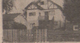
2241 E 12街樓上四睡房 土庫完成, 地大
