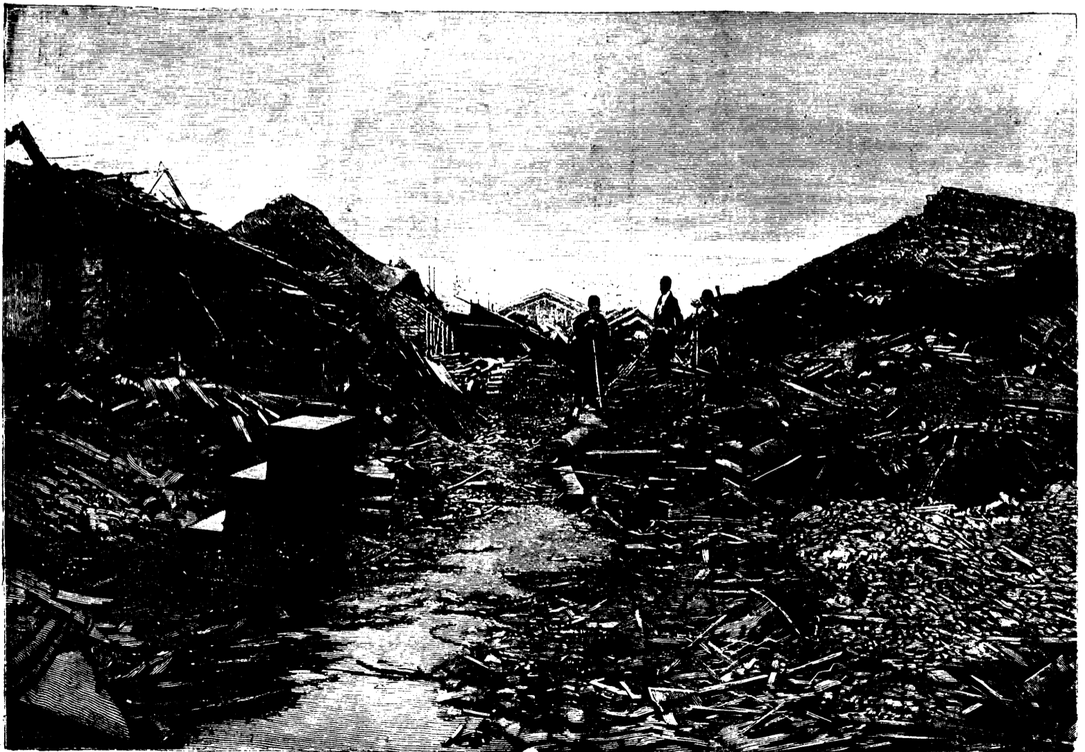
TERRIBLE TREMBLEMENT DE TERRE AU JAPON. — LES RUINES A GIFU
