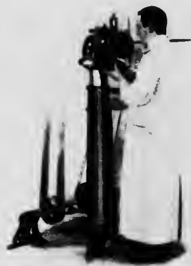
MACHINE GOODYEAR À BROCHER LAQUELLE FAÇONNE LA SEMELLE DE LA CHAUSSURE SUIVANT LE CONTOUR DE LA FORME
