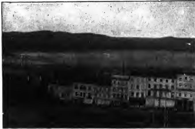
VUE DE LA RUE DE LA FABRIQUE, DANS LA DIRECTION DE BEAUPORT
