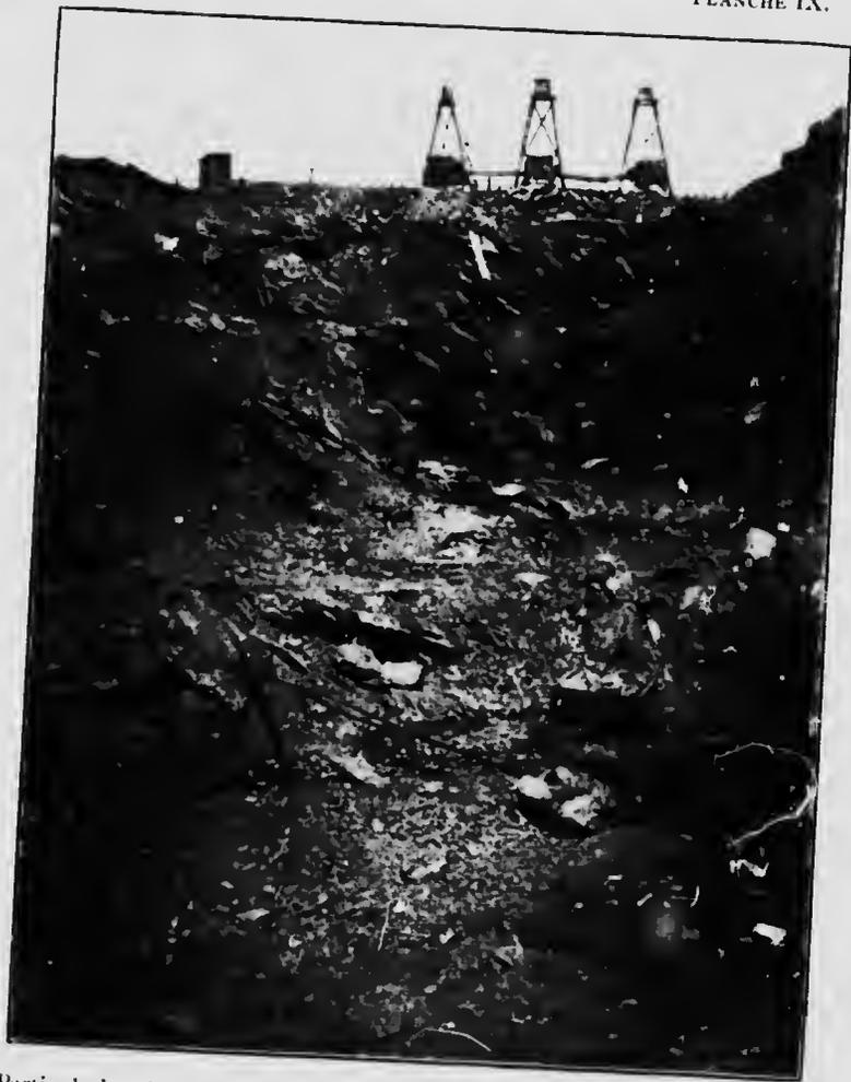
Partie de la mine d'amiante Ling, Broughton Est, Qué. La roche est friable et peu compacte et peut être extraite avec très peu de sautage.
