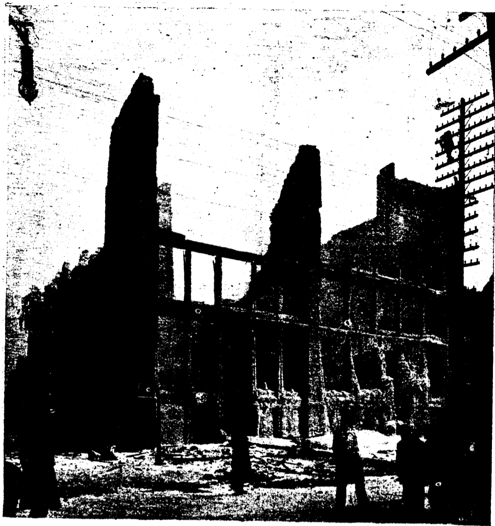
MONTREAL.—L'INCENDIE DU 20 FÉVRIER : VUE DES RUINES A L'ENCOIGNURE DES RUES DU COLLÈGE ET SAINT-HENRY
