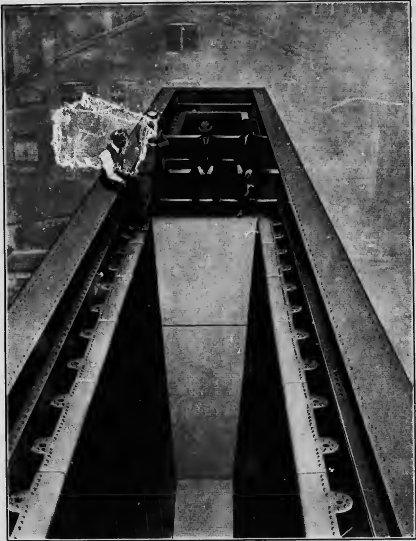
Intérieur d'un haut fourneau, installation d'Anyox, Grandy Consolidated Mining & Smelting Co., Anyox, C.B. (Traylor Eng. Mfg. Co.)
