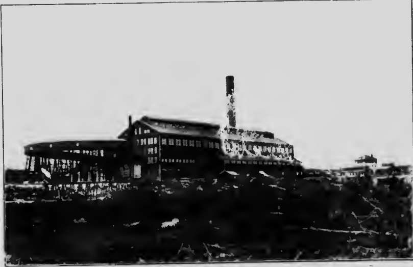
A. Vue d'ensemble de l'installation achevée de Coniston. On remarquera le tramway élevé de forme courbe qui passe au-dessous des réservoirs à minerais et au-dessus du niveau de chargement des fours.
