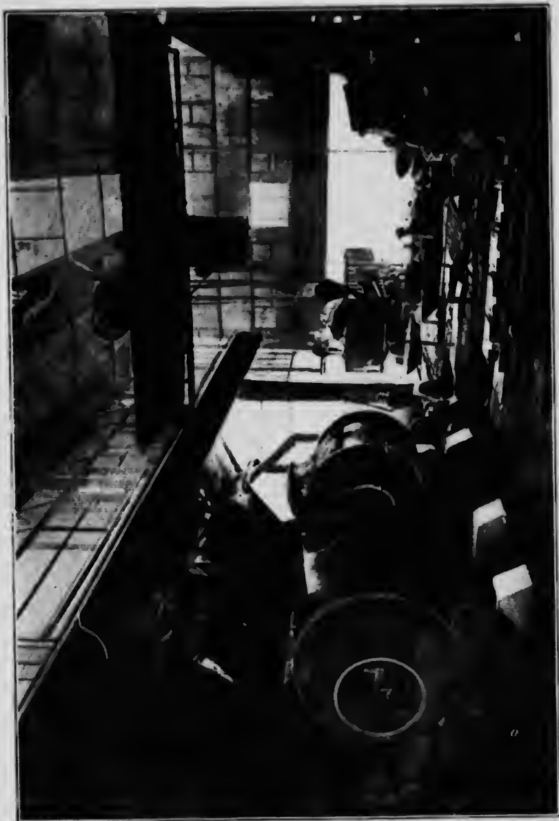
Convertisseurs à cuivre acides, British Columbia Copper Co., Greenwood, C. B.
