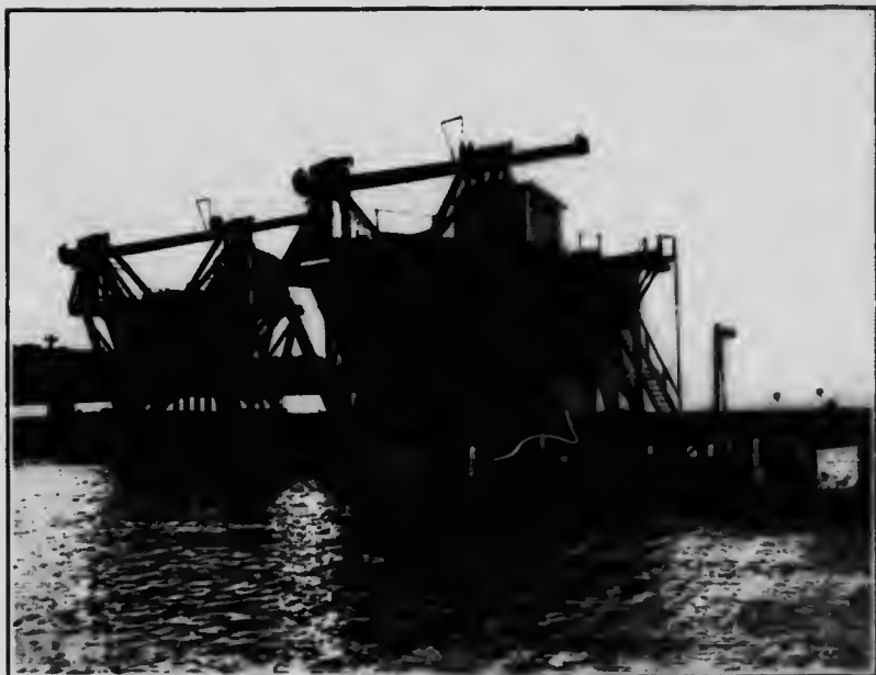
A. Déchargement des sîles à minerais.
