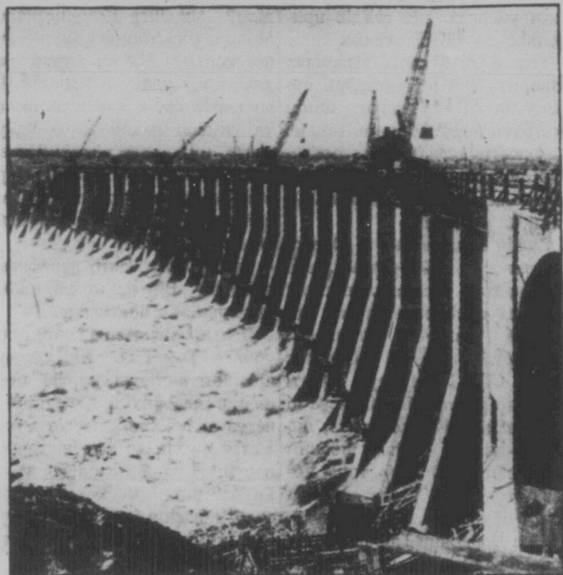
ЗАЛІЗНО-БЕТОННА ГРЕБЛЯ ЧЕРЕЗ ДНІПРО КОЛО ПОРОГІВ — ЕЛЕКТРИЧНЕ СЕРЦЕ УКРАЇНИ, ЯКЕ ДАСТЬ ВЖЕ СВОЄ ПЕРШЕ СВІТЛО І СИЛУ ДНІПРОКОМБІНАТОВІ 1 ТРАВНЯ 1932 РОКУ.
