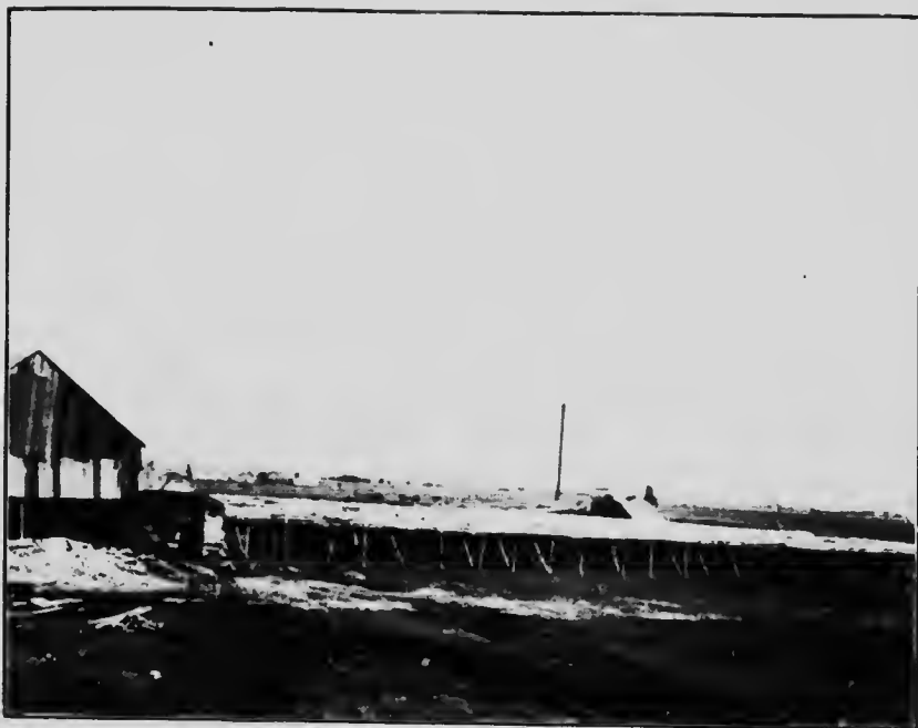
Claies de séchage pour briques en pâte molle - Gate City Brick Co., Winnipeg, Man.
