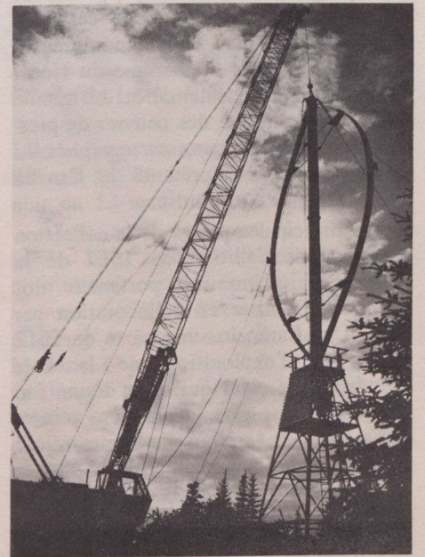
Mise en place d'une turbine éolienne à axe vertical de 50 kW dans l'île de Vancouver.
