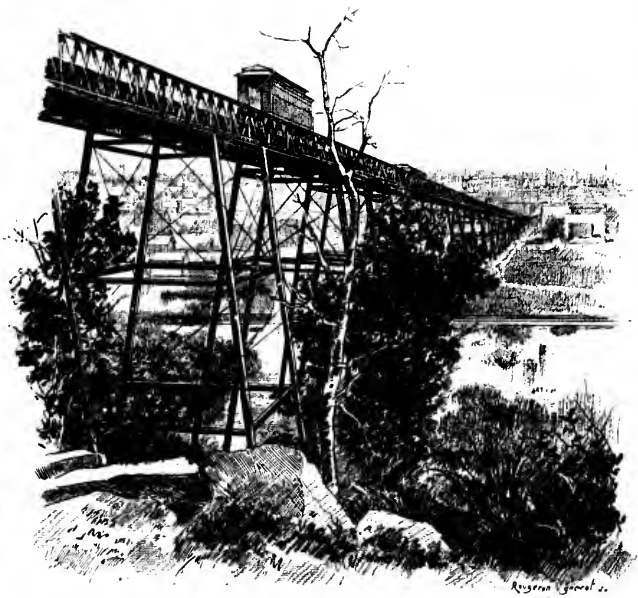
Le cable-roof d'Hoboken.
