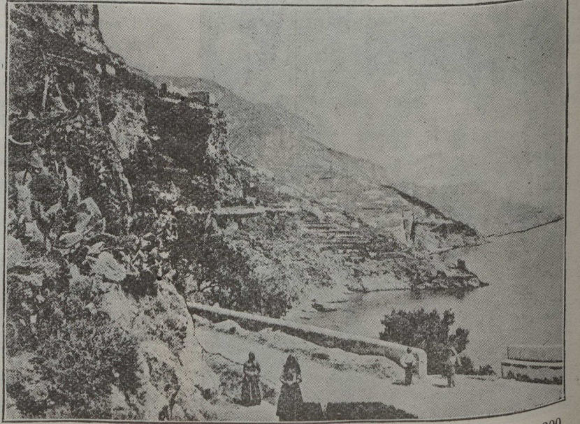
Le rivage occidental de la Calabre, en Italie, près de Palmi, où plus de 300 maisons sont en ruines.
