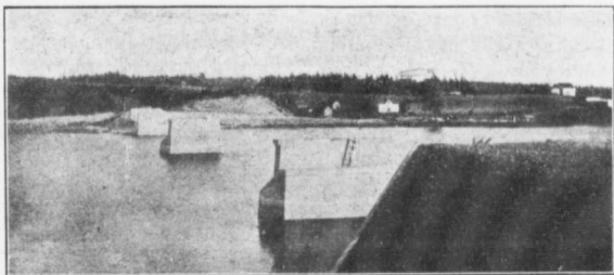
Témiscaming-Nord. Pont du Gouvernement (en construction).
