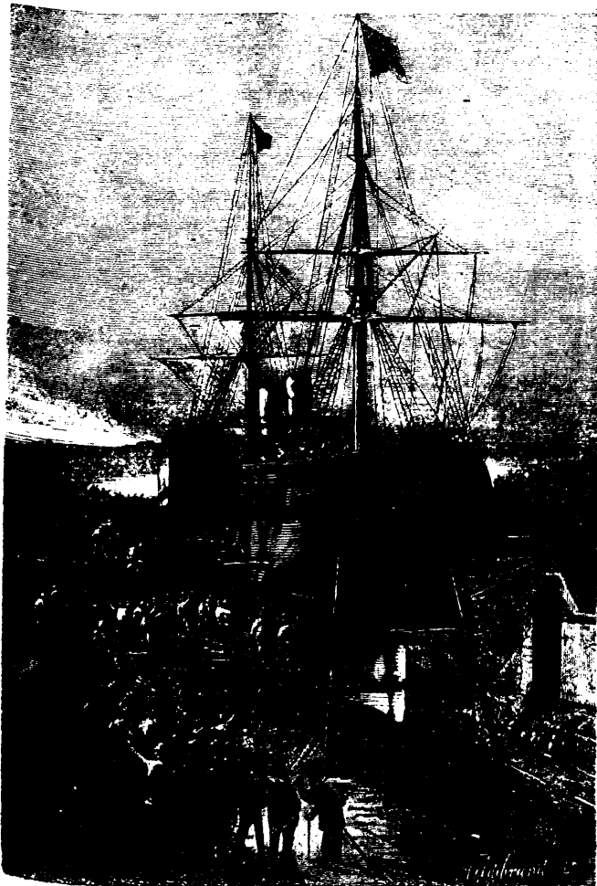
Le Vapeur Scotia dans les Dry-Docks (p. 15, col. I.)
