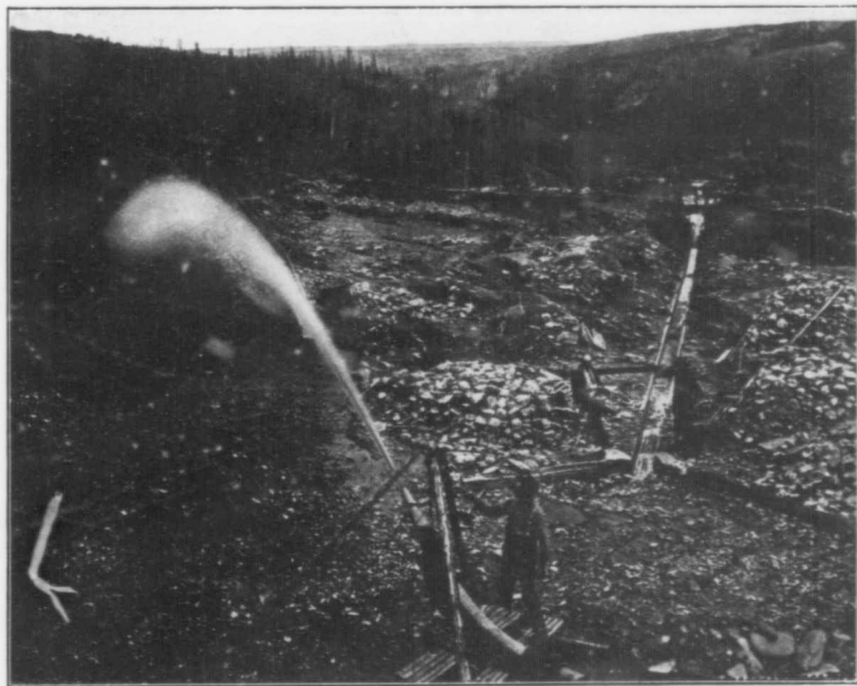
Petit abatage hydraulique de matériaux gelés Gold Creek, Yukon.
