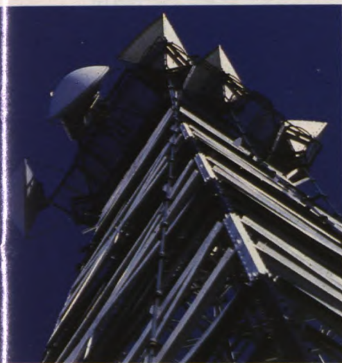
Communications numériques hyperfréquences . . . Une des tours de la double chaîne transcontinentale de trajets radio hyperfréquences de TÉLÉCOM CANADA. Une partie importante de ce réseau fonctionne selon des techniques de transmission numériques.
