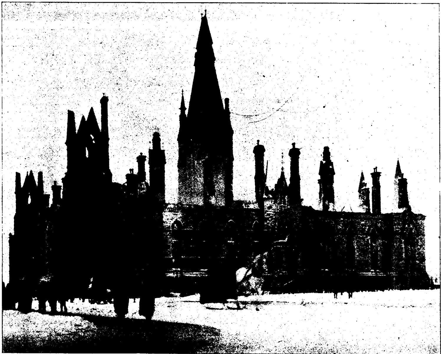
OTTAWA.—L'édifice de l'Ouest (bâtisse du Parlement) après l'incendie
