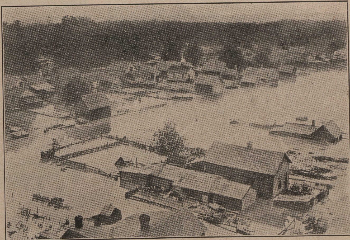
VUE D'UN COIN DE LA CITÉ DES MOINES, IOWA, OU UNE RÉCENTE INONDATION A CAUSÉ DE NOMBREUSES PERTES DE VIE
