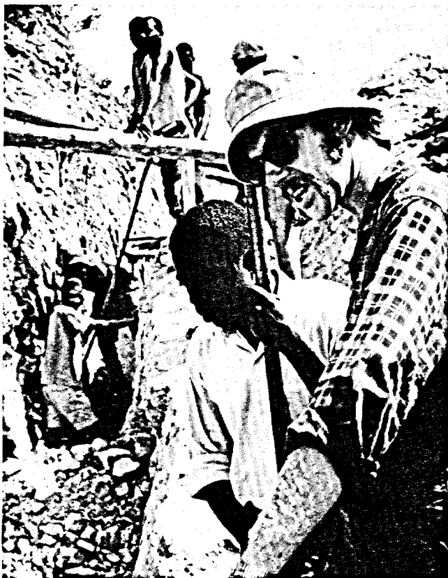
John Campbell, ingénieur ontarien au service de l'ACDI, dirige la construction d'un système d'égouts à Blantyre au Malawi.
