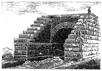
FIG. 3.—CULVERT UNDERNEATH EMBANHMENT.—INTERCOLONIAL RAILWAY.
