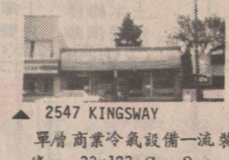
▲2547 KINGSWAY 單層商業冷氣設備一流裝 修，33x123 C-2， $288,000
