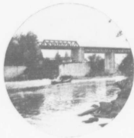
G. T. R. BRIDGE, KINGSTON MILLS.
