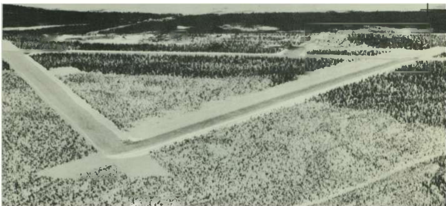
Construction de l'aéroport de Goose Bay. Mars 1942.
