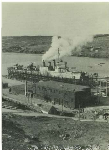
Contre-torpilleur endommagé en réparation à Bay Bulls. Mai 1944.
