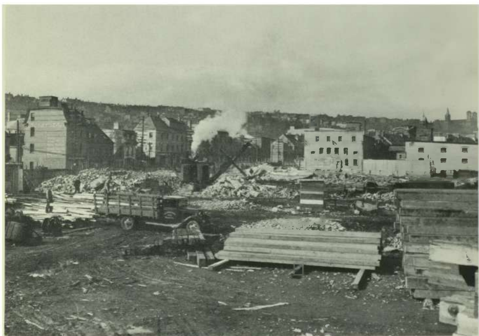
Début de la construction des installations portuaires de la MRC. St. John's, septembre 1941.
