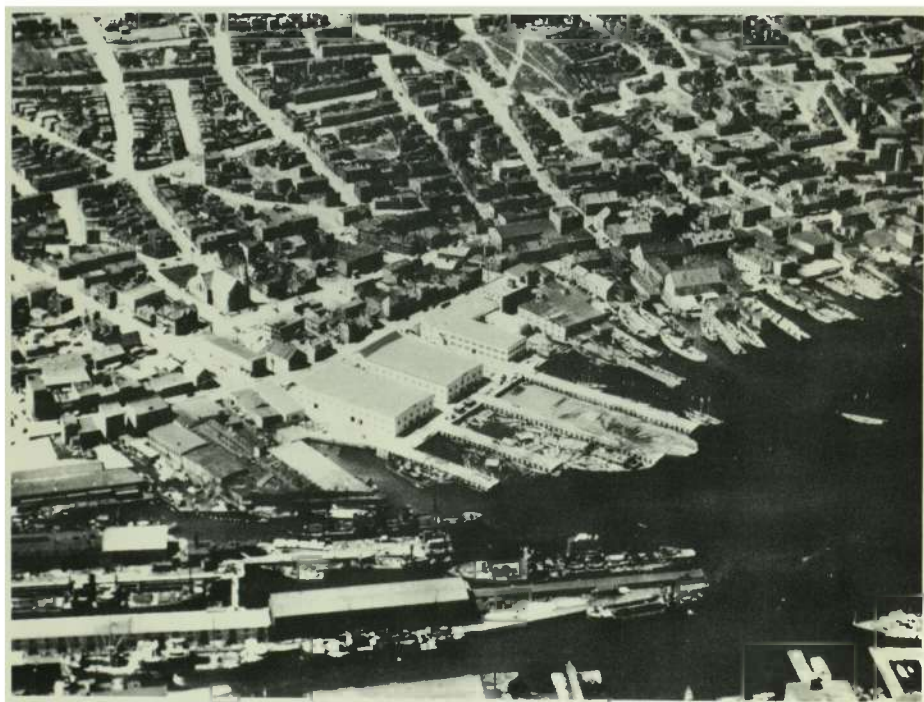
Les installations portuaires de la MRC vers la fin des travaux, St. John's, mai 1942.
