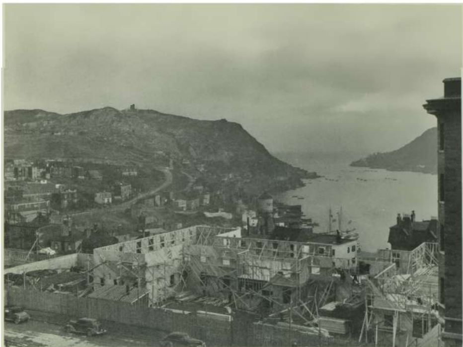
Construction des quartiers généraux de la MRC à St. John's. À l'arrière-plan on aperçoit les filets anti-torpilles. Novembre 1941.
