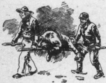
Epi on le ramène du chantier.
