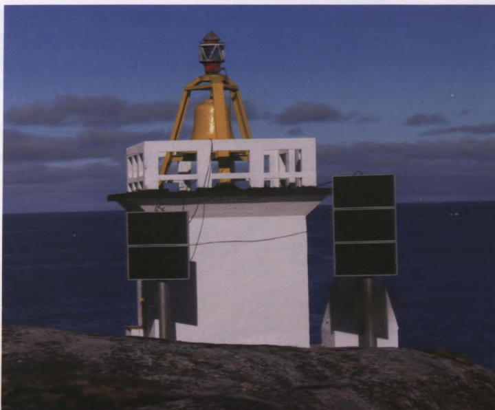
Les panneaux solaires offrent une source durable d'énergie de remplacement pour les phares autrefois alimentés par des matières hautement radioactives
