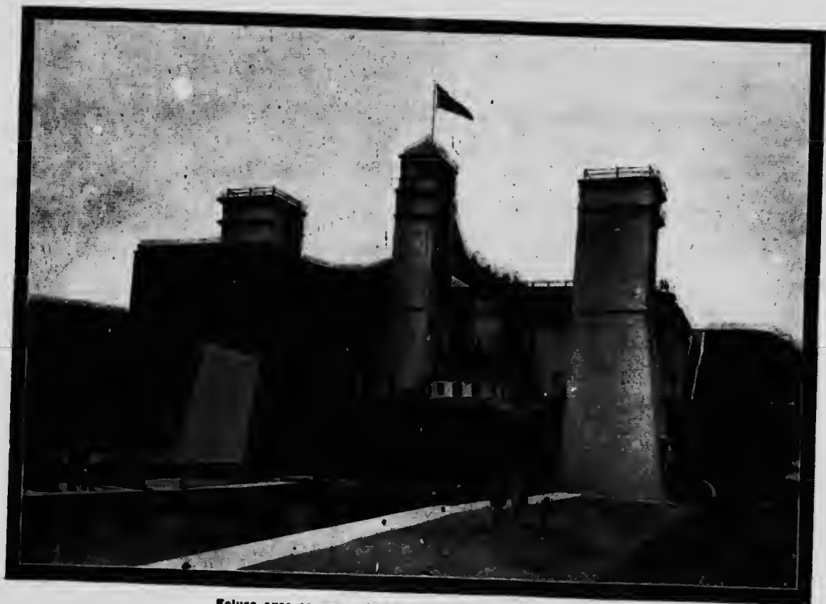
Ecluse avec ascenseur hydraulique, à Peterborough (Ont.)
