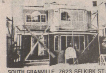
SOUTH GRANVILLE 7623 SELKIRK ST. 新屋六月完成, 地大 33' x 122' 全磚二層四房呎價 519,000
