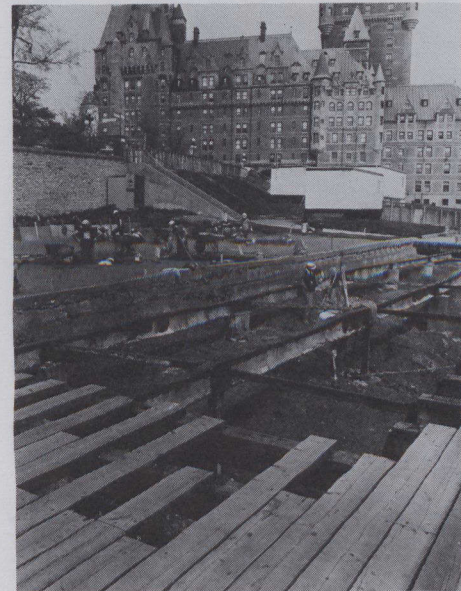
Travaux d'excavation près de l'hôtel Château Frontenac à Québec.
