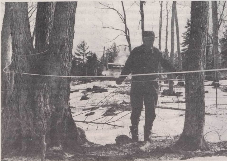
Nouveau système utilisant des tubulures de plastique pour la cueillette de la sève.
