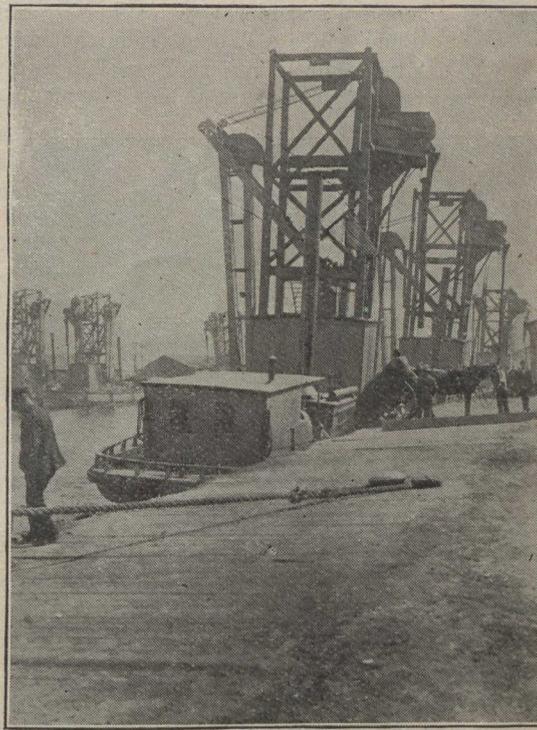
Des élévateurs flottants servent à décharger les barges et à charger les paquebots
