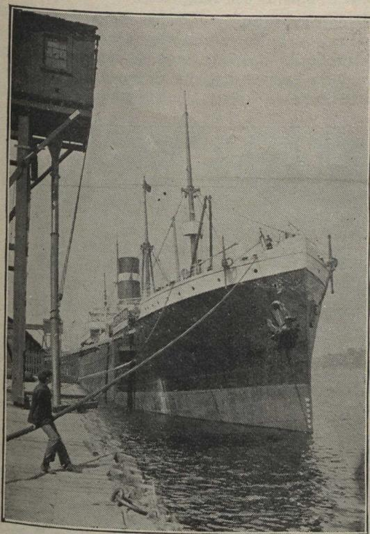
Au moyen de cables tirés par des cable-tans mécaniques les navires sont amenés au quai
