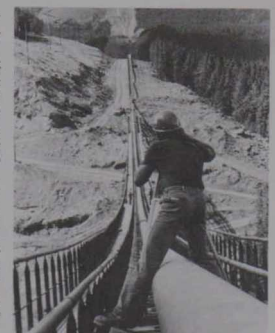
掘り出し現場から洗浄プラントへ延びる13キロのコンベア。
