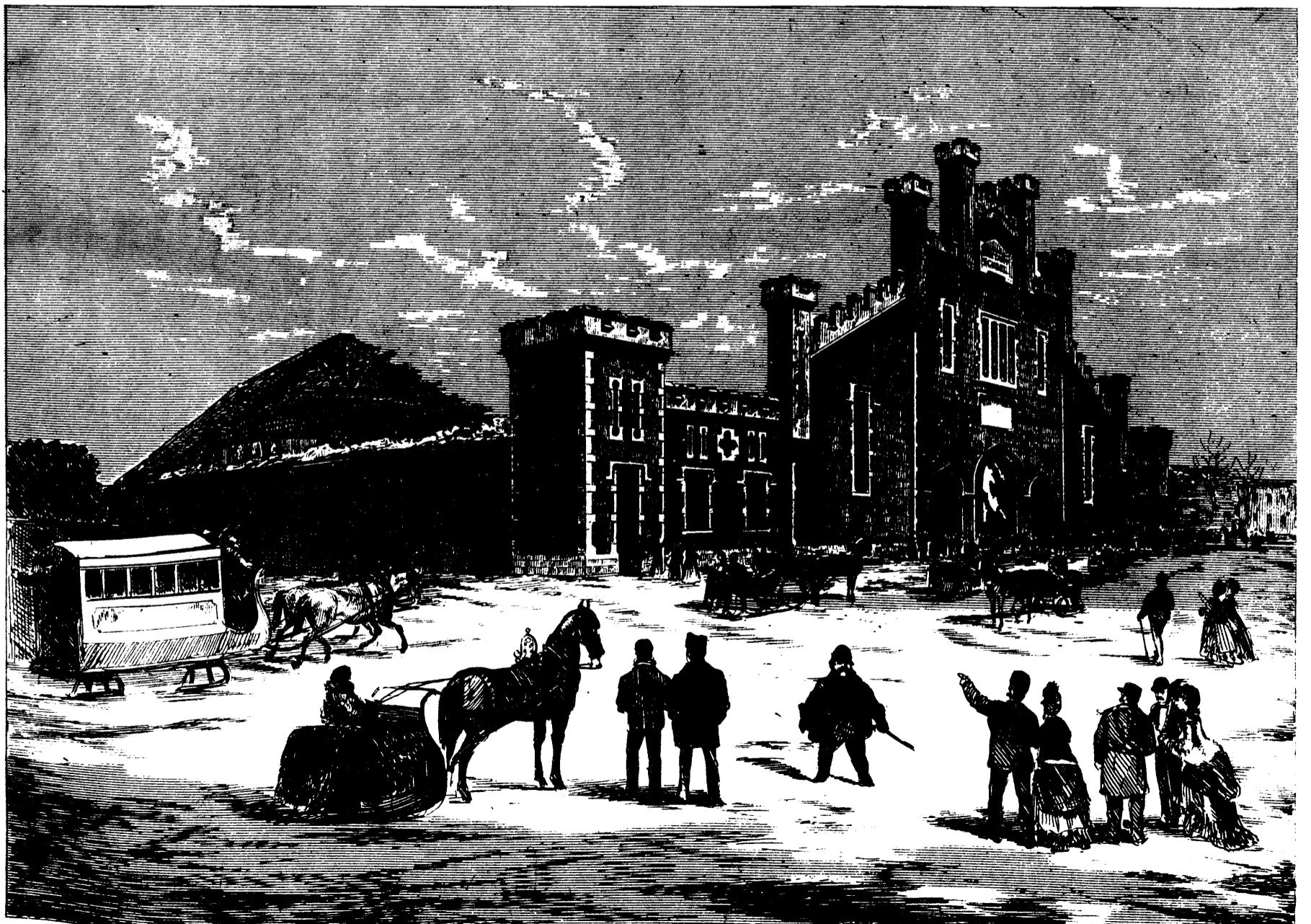
ASPECT DE LA SALLE D'EXERCICE, MONTRÉAL, APRÈS L'EFFONDREMENT DU TOIT DANS LA SOIRÉE DU 23 JANVIER DERNIER.
