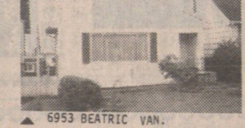
▲ 6953 BEATRICE VAN. (城多利 53 街) 樓上 2 房樓下 2 房 2 睡房，新裝修，修外牆，鋁窗門，黃光照 645-3232
