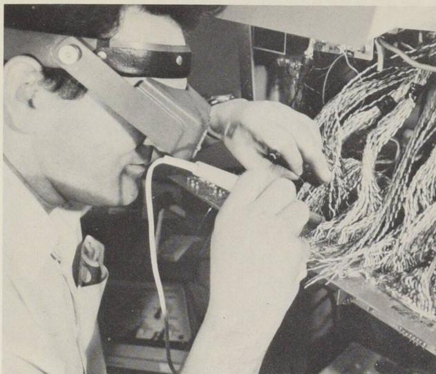
Une des importantes caractéristiques du télescope spécialement conçu pour étudier les rayons cosmiques est le contrôle permanent de tous ses éléments par un ordinateur central. Les terminaisons nerveuses du télescope entrent ici dans une unité de traitement.
