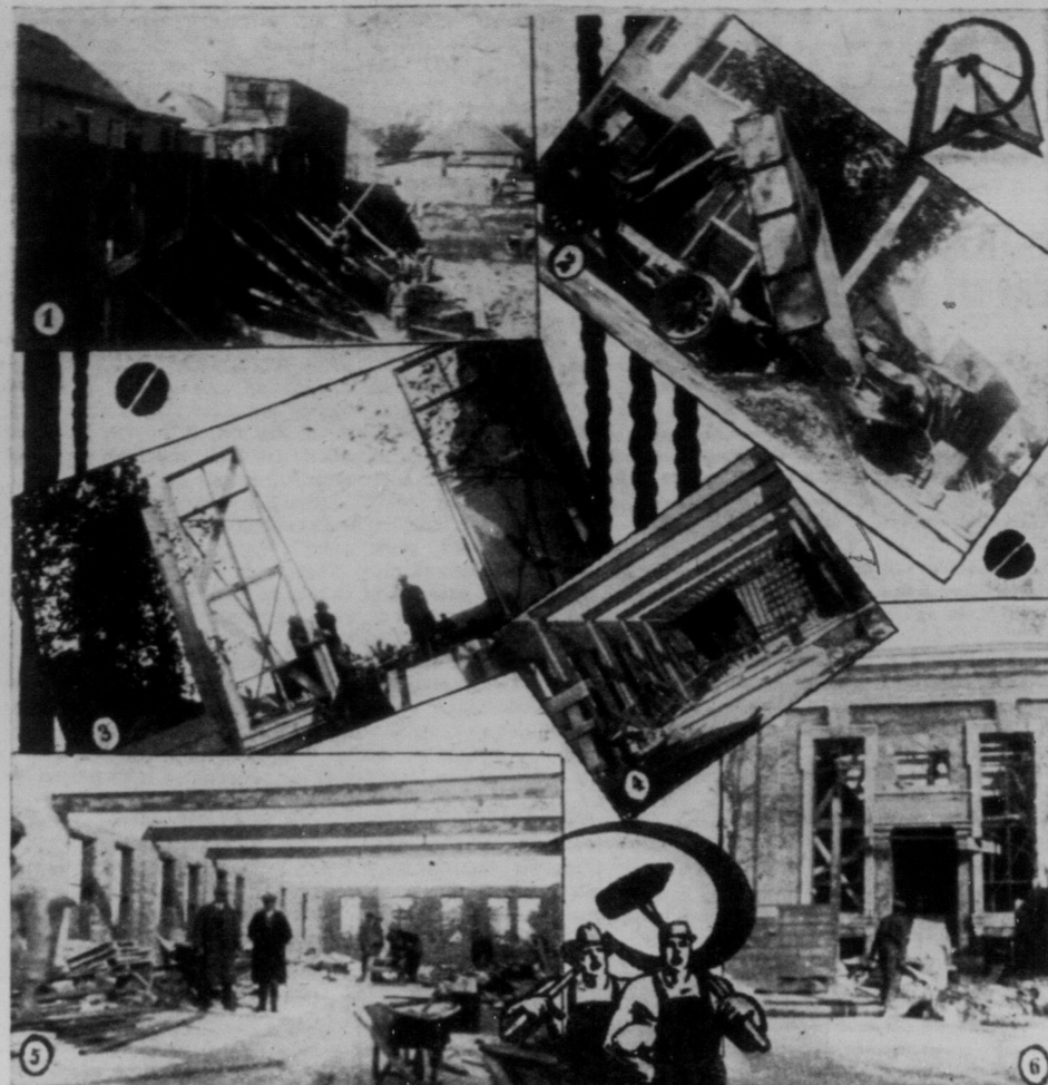
На цих образах показано, як поступає будова будинку для друкарні, школи й редакційних та центральних зарядів офісів. На образах показано: 1. копання пивниці; 2. цементування стін пивниці; 3. встановлення фронтних вікон; 4. зала школи; 5. останній поверх, на якому будуть офіси; 6 фронт будинку. Муровання вже закінчено. Друкарня буде в пивниці під цілим будинком і на образку її не показано.
