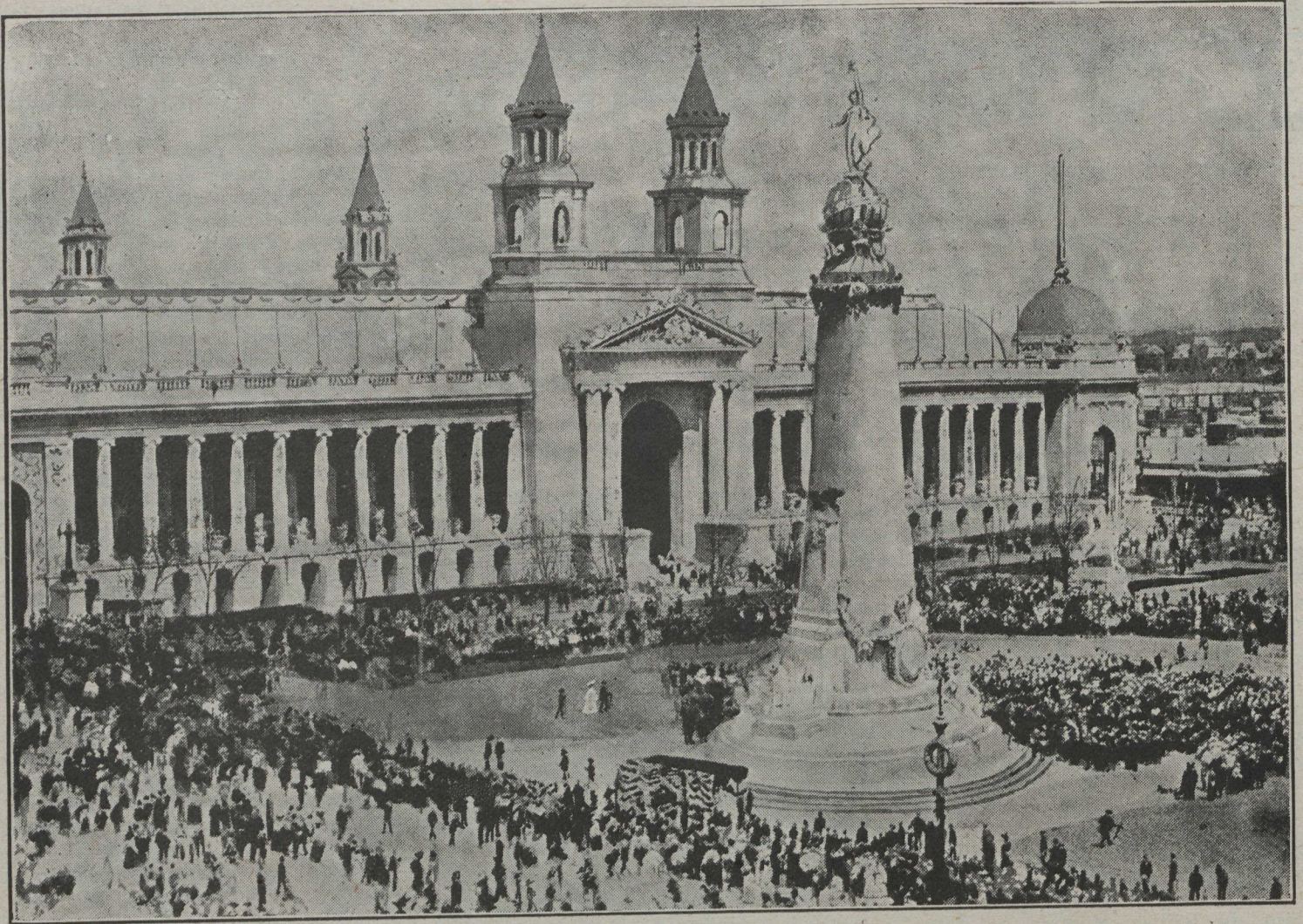
EXPOSITION DE SAINT-LOUIS — La foule assiste à son inauguration, au pied du monument qui commémore l'achat de la Louisiane; monument qui se trouve en face du palais des industries variées.
