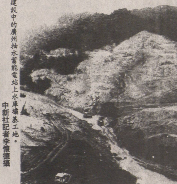
建設中的廣州抽水蓄能電站上水庫壩基工程。
