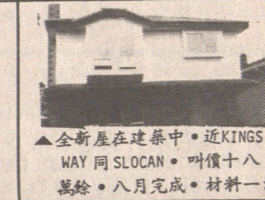
▲全新屋在建中。近 KINGS WAY 同 SLOAN。叫價十八 萬餘。八月完成。材料一流
