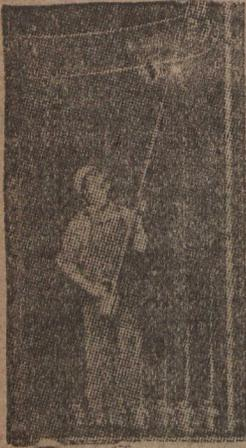
POUR huiler les poulies et les roues de transmission sur les arbres de couches dans les usines ou les manufactures, on se sert généralement d'échelles ou d'esca-beaux. Malheureusement ces échelles ou escabeaux sont assez dangereux, car un seul faux mouvement de
