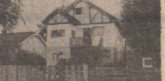
2241 E 12街樓上四睡房 土庫完成, 地大
