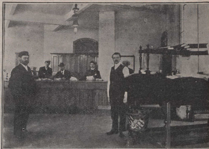
Bureau du Surintendant de l'entrepôt
