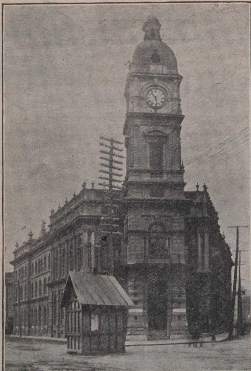
L'édifice principal de la Douane à Montréal
