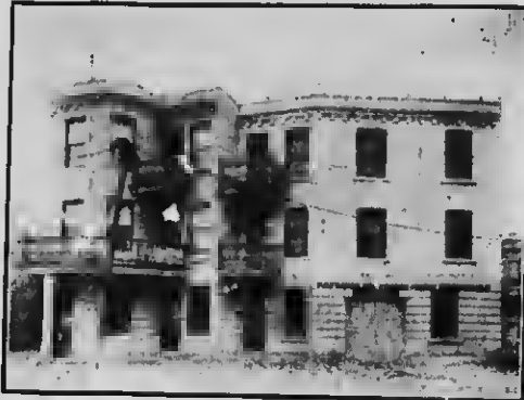
Résidence et Manufacture, construites en pierres artificielles, imperméables, au ciment.—Propriétés de M. P. N. Trahan.
