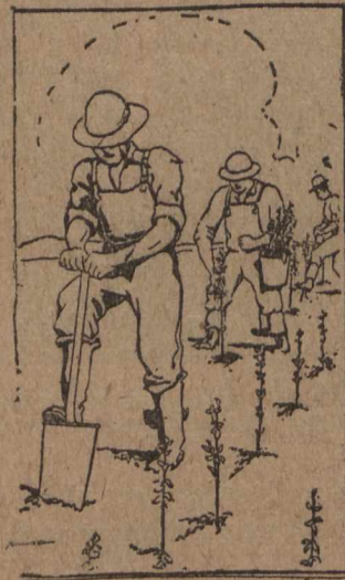
Ouvriers se servant de la pelle. Ancienne manière.
