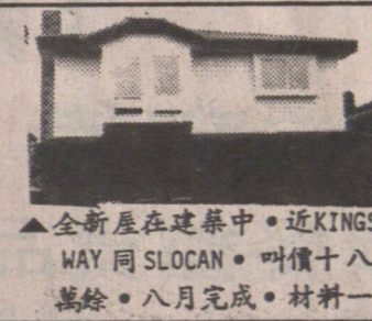
▲全新屋在建中。近 KINGS WAY 同 SLOAN。叫價十八 萬餘。八月完成。材料一流
