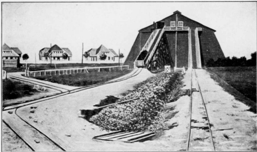
Emmagasinage de la tourbe; trémie d'une capacité de 2,000 tonnes métriques; habitations des ouvriers à l'arrière-plan.
