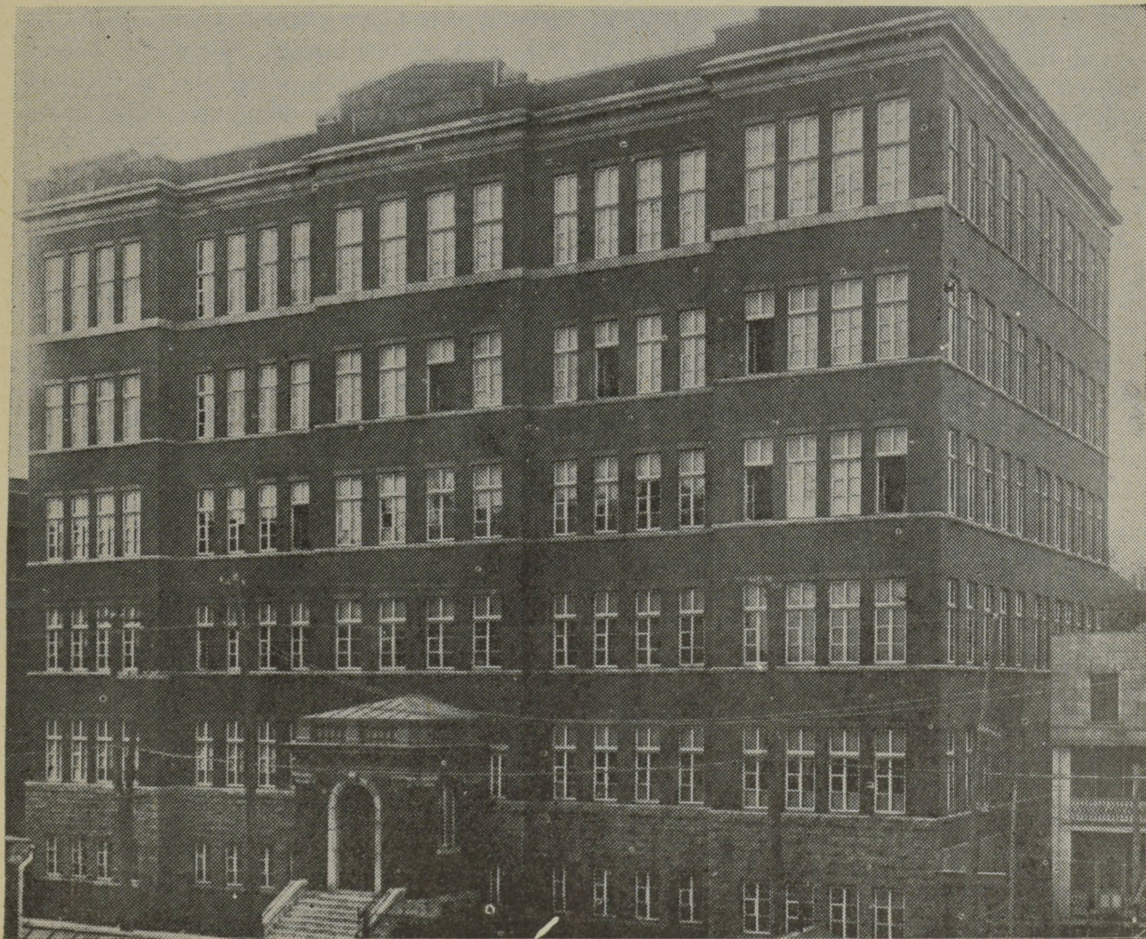
LE PENSIONNAT ST-JEAN BERCHMANS DE QUÉBEC qui a été complètement détruit par un incendie.
