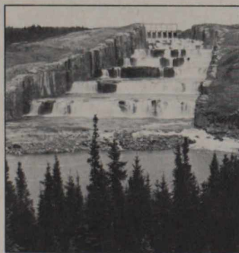
Évacuateur de crues.
