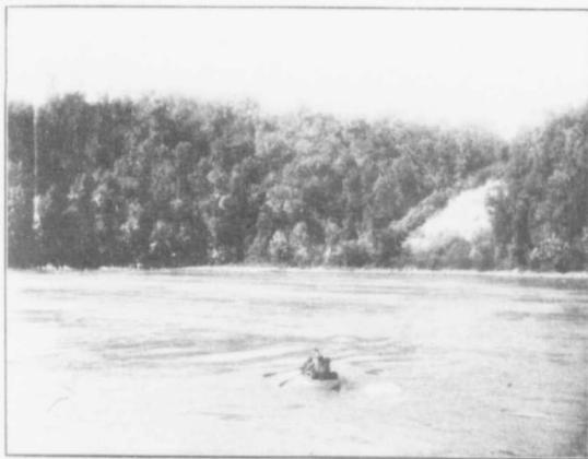
Vue de la fin du Whirlpool avec l'embarcation portant le câble transversal pour pratiquer les sondages.
