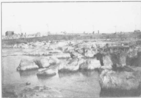
Vue du lit de la rivière à l'avant-baie de l'Electrical Company quand l'eau a été asséchée. Les jointages de la roche de fond ouverts par la dissolution du calcaire laissant séparés les massifs restés en place.
