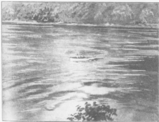
Vue de l'embarcation traversant les rapides juste en aval du déboucé du Whirlpool et portant un câble de l'autre côté de la rivière pour pratiquer les sondages.
