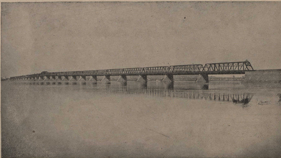
Vue générale du Pont Victoria (cliché du Grand Tronc)
