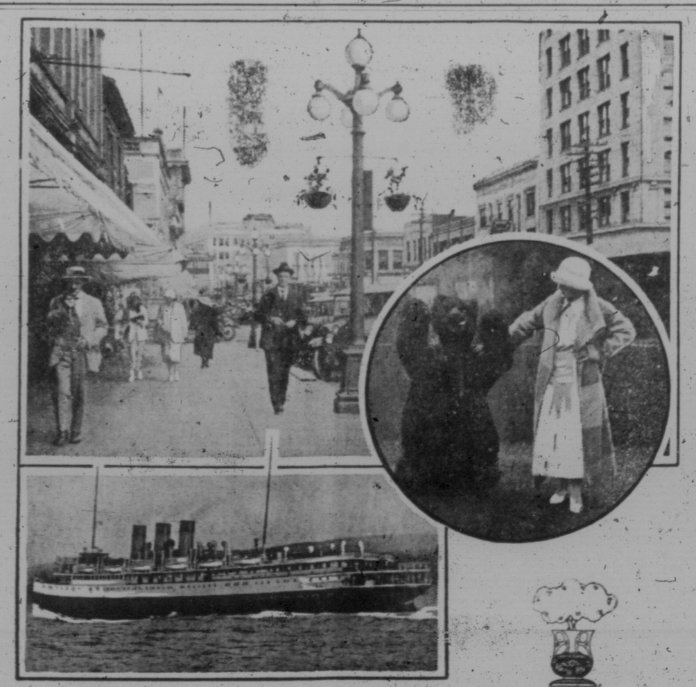
Ober: Ein Blick in das Geschäftsviertel von Victoria, der Hauptstadt von British Columbia. — Unten: „Prince of Wales“, eines von den drei neuen Schiffen, welche in den Dienst des Schiffsverkehrs zwischen Vancouver, Victoria und Seattle gestellt werden. — Das runde Bildchen: Aus der Bendray Gardens, die eine gartenbühnliche Sehenwürdigkeit von Victoria darstellen.
